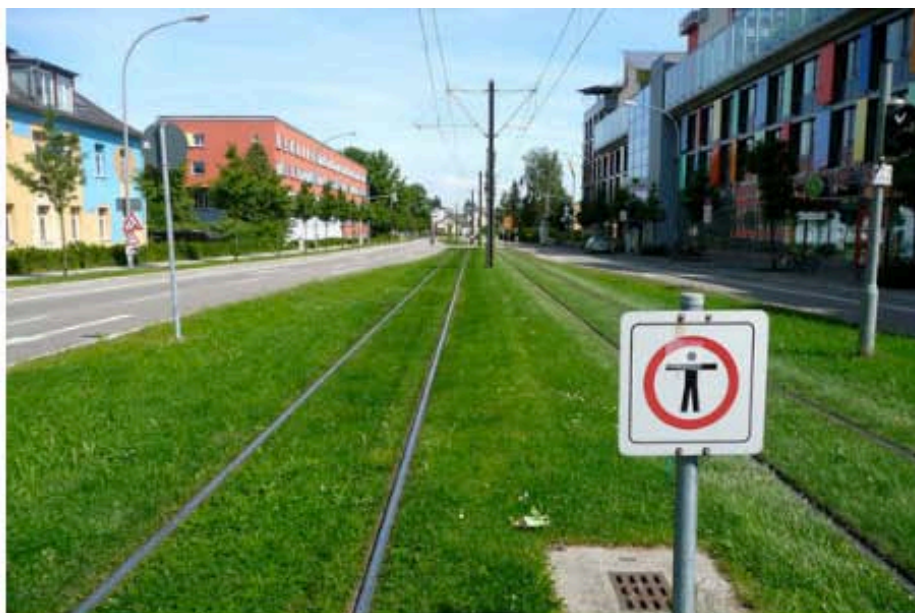
Le linee tranviarie nel quartiere Vauban a Friburgo corrono su nastri verdi per garantire naturalità del suolo
