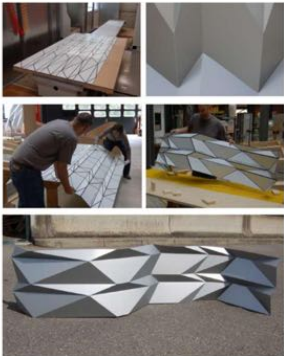
Figura 74– Fresatura e piegatura dei pannelli “Alucobond” (Buri, 2010)
