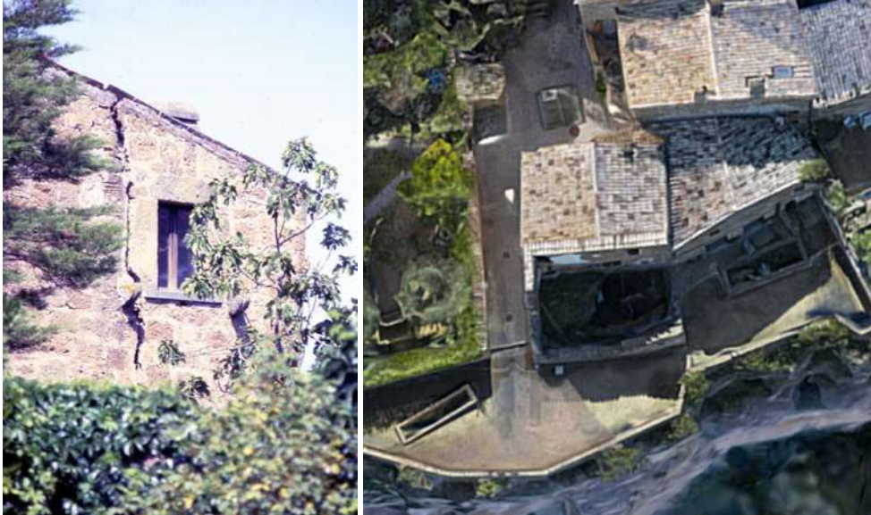
Casa Greco: Condition in 1986 / 3D scan
