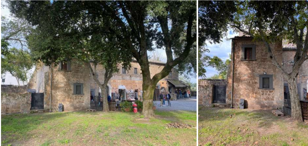
Belvedere di S. Francesco Vecchio: Current Conditions
