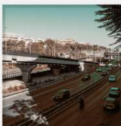
Viadotto Via delle Valli
