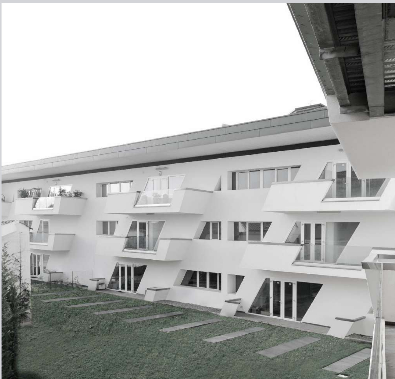
REMAC - VISTA DELLA FACCIATA INTERNA CON I BALCONI DEL RESIDENZIALE
