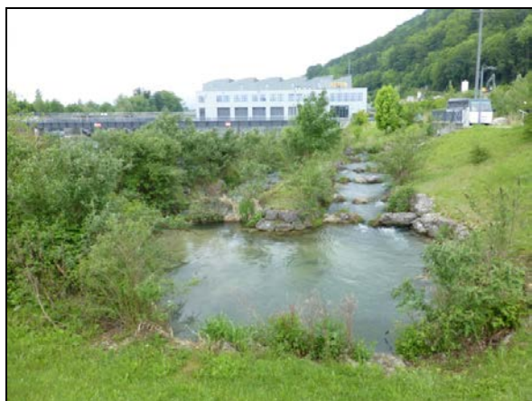
Centrale di Ruppoldingen (Svizzera), particolare delle misure adottate per il passaggio dei pesci e la conservazione dell'habitat: foto gentilmente concessa da Jukka Jormola, SYKE
